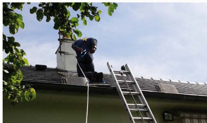
Exercice de manœuvre sur les toits pour intervention sur nid de guêpes
