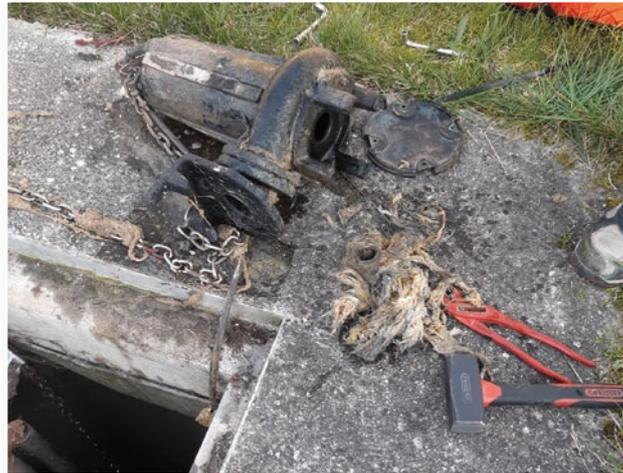
Constat est fait les pompes de la station de relevage des eaux usées sont à l'arrêt ! Des filaments en empêchent le fonctionnement ; les fameuses lingettes.
