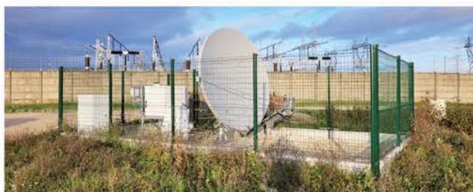
Depuis quelques semaines, des promeneurs sont intrigués par la présence d'une grosse antenne parabolique installée à côté du poste 400 kV de RTE. Cette antenne sert d'interface entre le réseau satellitaire VIASAT (*entreprise américaine spécialisée dans les télécommunications par satellite*) et le réseau de fibres optiques excédentaires installées sur les réseaux de transport d'électricité.
